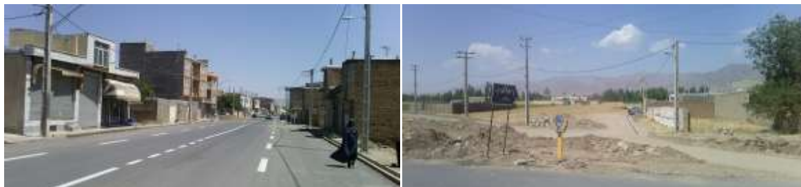
شکل ۱۰. ایجاد جاده (زیرسازی‌های ارتباطی)
